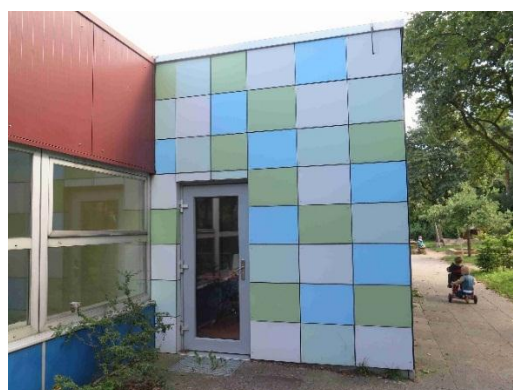
Gebäudeanbau mit 3-fach-Wärmeschutzverglasung
