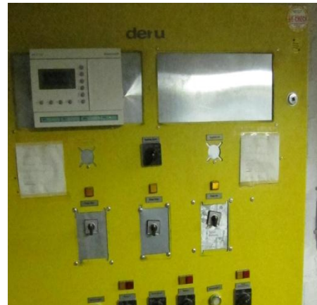
Regelung der Heizungsanlage
