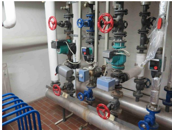
Heizkreisverteiler mit Umwälzpumpen
