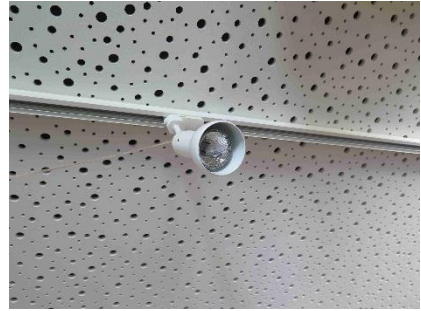
Hallenbeleuchtung einflammig 58W Halogenspot 50 W
