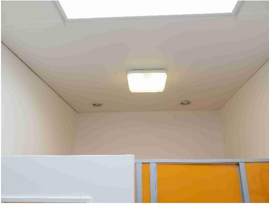
Lüfter über Deckenventilator
