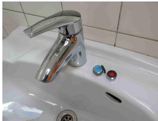
Austausch der Perlatoren durch Sparperlatoren
