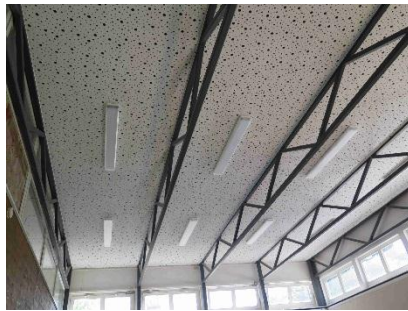
Hallenbeleuchtung einflammig 58W Halogenspot 50 W
