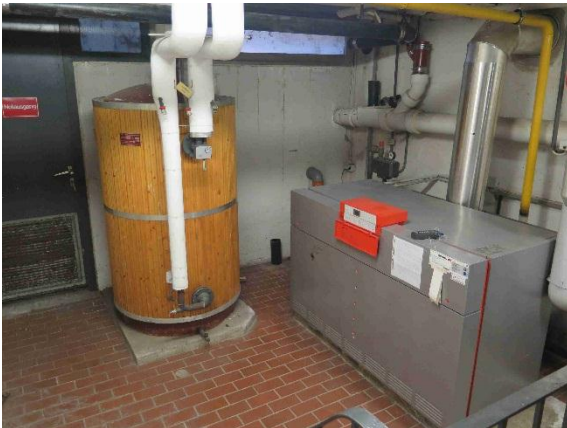
Gas-Kessel und WW-Speicher
