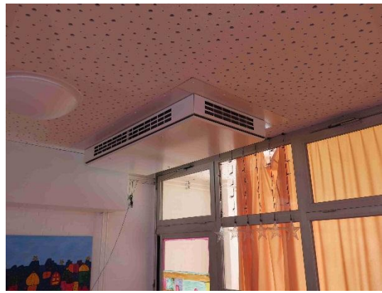
Lüftungsanlage für einen Raum
